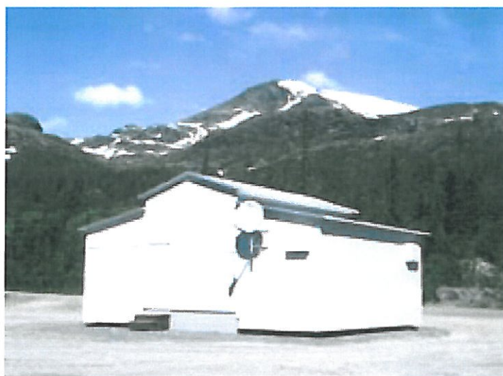
Inomhusställverk vid Stora Sjöfallet
