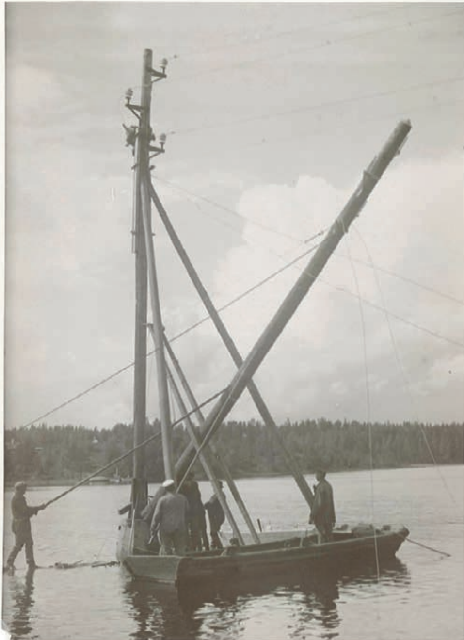
Resning av ledningsstolpar - (Svensk Energi)
