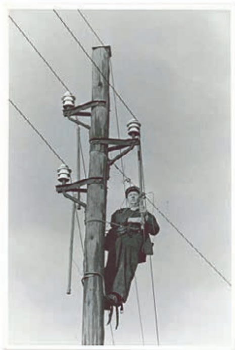
Kabelreparation 1938 - (Svensk Energi)
