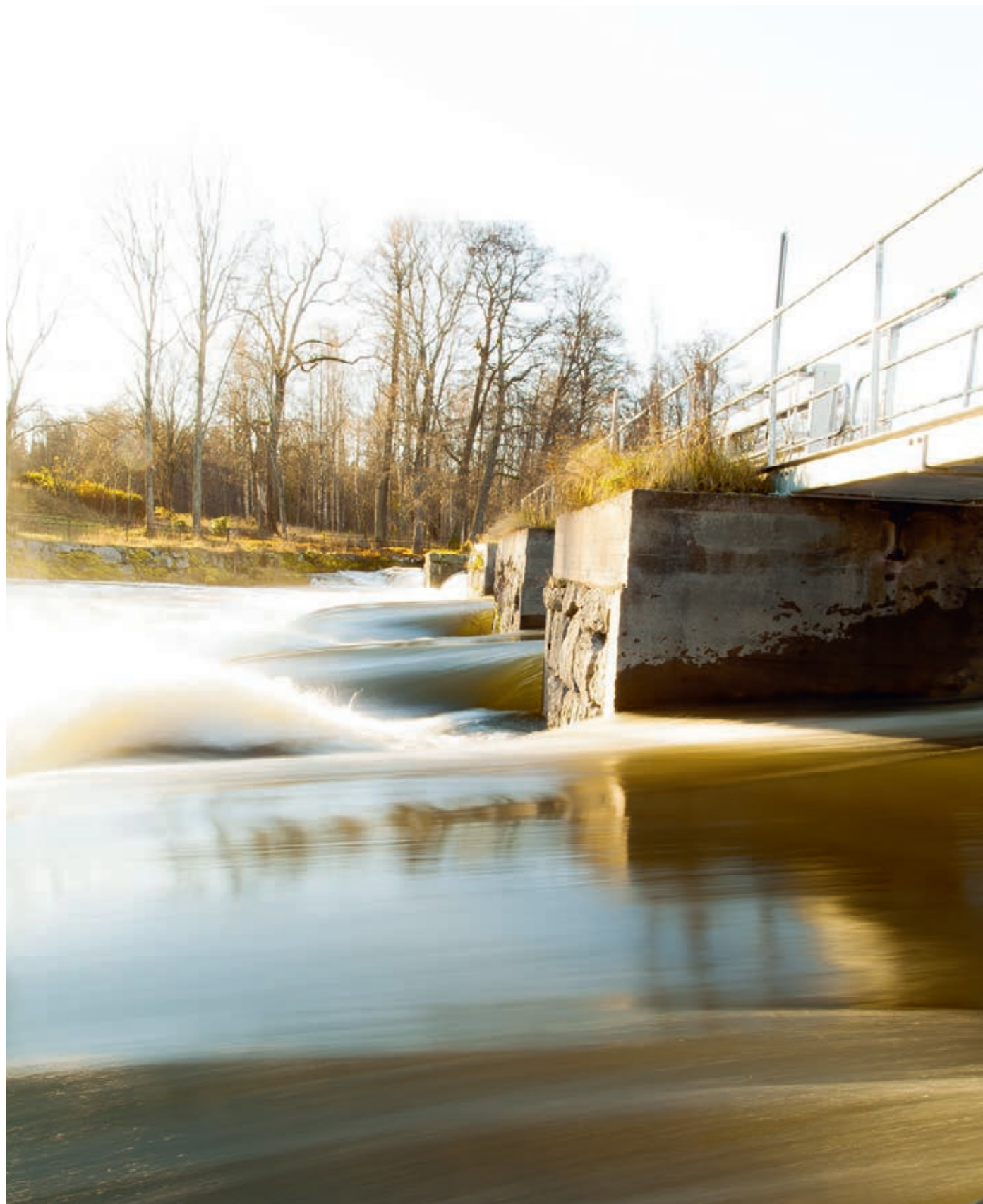
Forsen vid kraftstationen i Skogstorp, Eskilstuna - Foto: aStory
