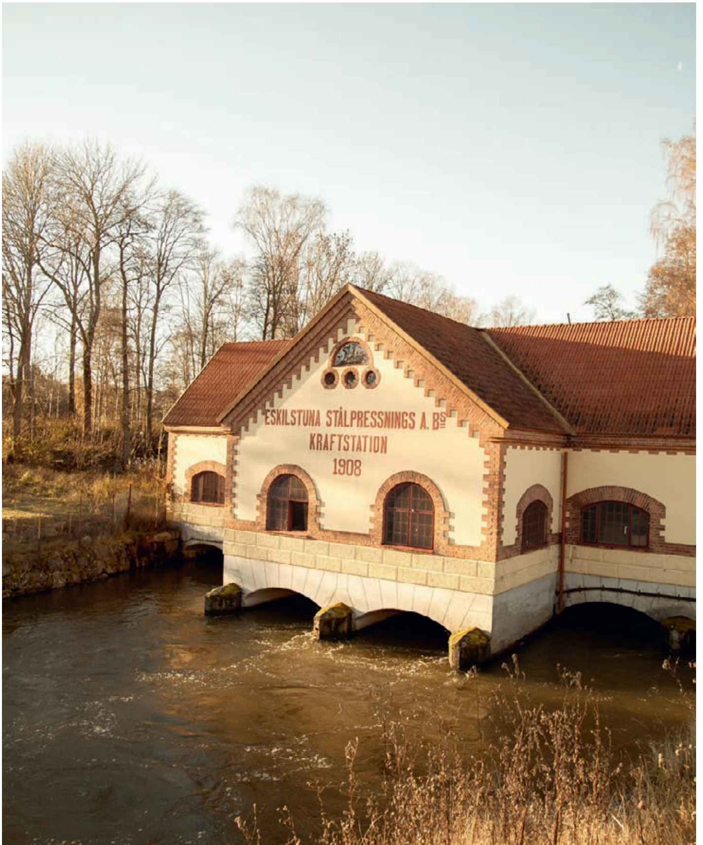
Kraftstionen i Skogstorp utanför Eskilstuna - Foto: aStory
