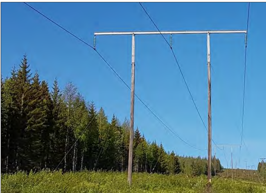
Figur 3-1. Exempel på en träportalstolpe med faslinor i horisontalplan. Ledningen på bilden har inte topplina.
