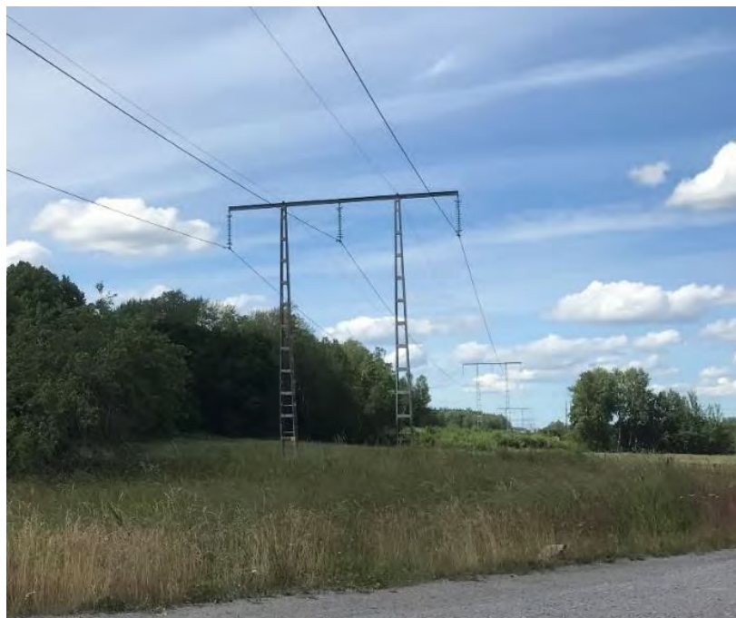
Figur 17. Foto på befintlig portalstolpe av KL42 S4-7 som ska rivas.
