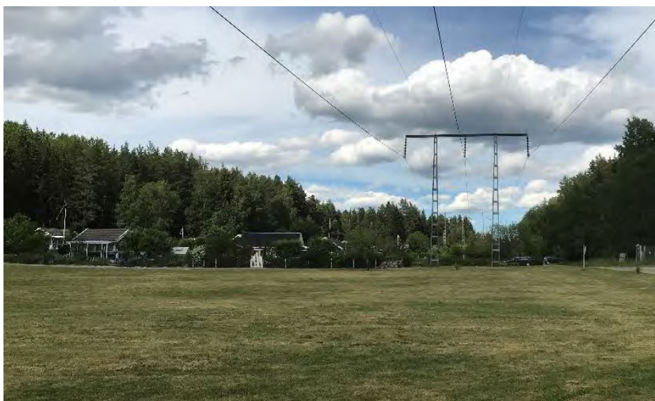
Figur 27. Befintlig ledning vid Vaxmyra kolonistugeområde, foto taget i nordlig riktning.
