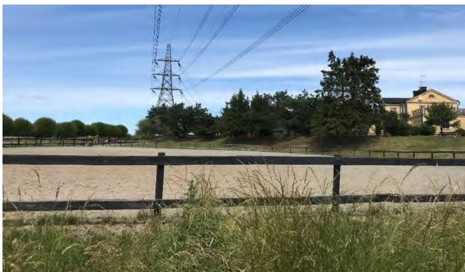
Figur 30. Befintlig ledning som idag går väster om Fjällsta gård. Utbyggnadsförslaget föreslås istället öster om gården längs befintliga ledningsgator för att minska påverkan på Fjällsta gård. Ledningen i bild kommer då rivas.
