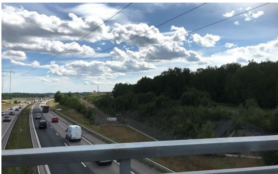
Figur 47. Befintlig 220 kV-ledning som korsar E4:an och Arlandabanan på flertalet platser mellan Brista och Upplands Väsby. Foto taget vid Rosersberg i sydlig riktning.
