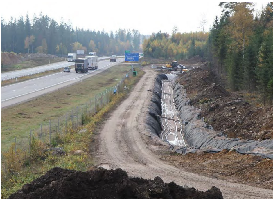
Figur 18. Exempel på markkabelförläggning av transmissionsnätet.
