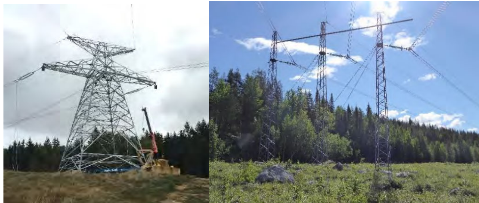
Figur 8. Exempel på vinkelstolpar, till vänster en variant som benämns stubbe och till höger traditionell vinkelstolpe (BV4-stolpe).
