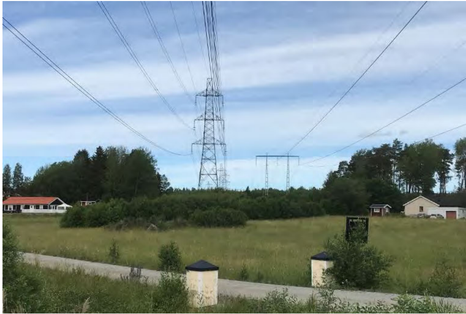
Figur 29. Boendemiljö och ledningsgata med befintlig sambyggd ledning (220 kV och 400 kV) samt en 220 kV-ledning (KL42 S8) strax söder om station Odensala. KL42 S8 ska avvecklas.
