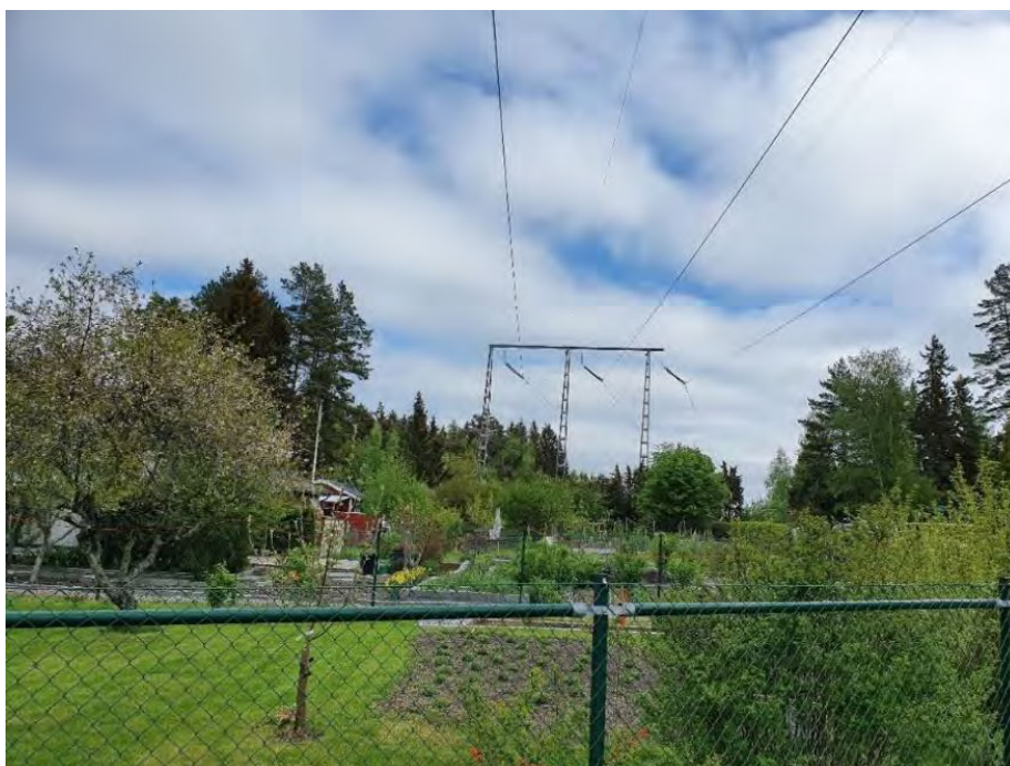
Figur 44. Befintlig ledning som idag korsar genom Vaxmyra kolonistugområde, foto taget i nordlig riktning.
