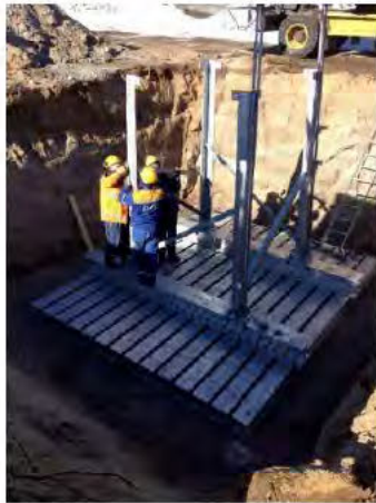
Figur 10. Foton som visar olika fundamentstyper, till vänster ett jordfundament med stålverk och stålslipers och till höger ett bergfundament
