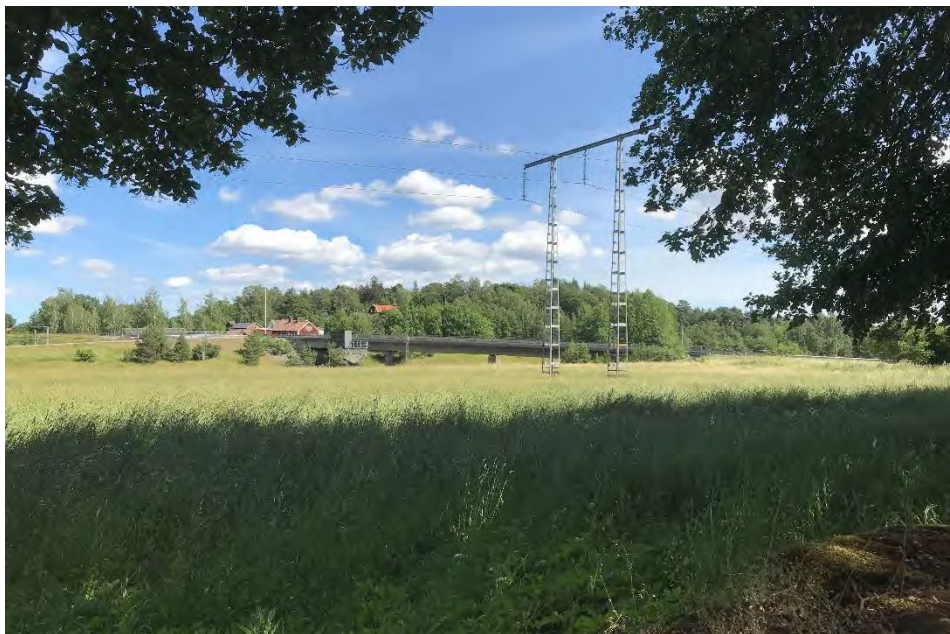
Figur 36. Vy från Norrsunda kyrka, med landskapsbildsskydd, befintlig ledning och Skobyvägens vägbro över E4:an.
