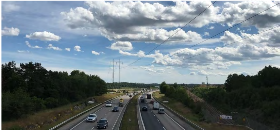
Figur 14. Befintlig 220 kV-ledning som idag korsar E4:an och Arlandabanan med ett tvärgående ledningsspänn vid Rosersberg. Foto taget i sydlig riktning.
