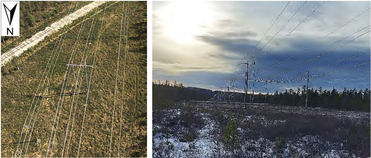
Figur 8. Befintliga ledningar (40 kV, 150 kV och 40 kV) vid korsning med järnväg. Vy från helikopter (vänster) och bild tagen i sydlig riktning (höger).
