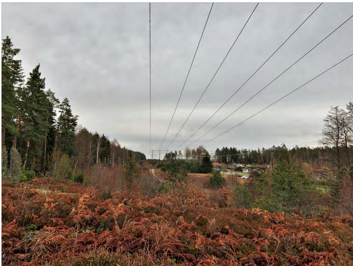
Figur 13. Befintliga ledningar vid sommarstugeområdet Myggdansen. Aktuell ledning planeras väster om befintliga ledningar. Bilden är tagen mot Tjusta; nordost.
