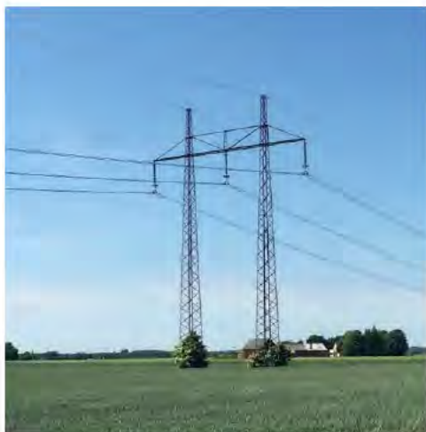
Figur 5. Exempel på ostagad portalstolpe (B-stolpe) och illustration av portalstolpe till höger som planeras mellan Måby och Skoby.
