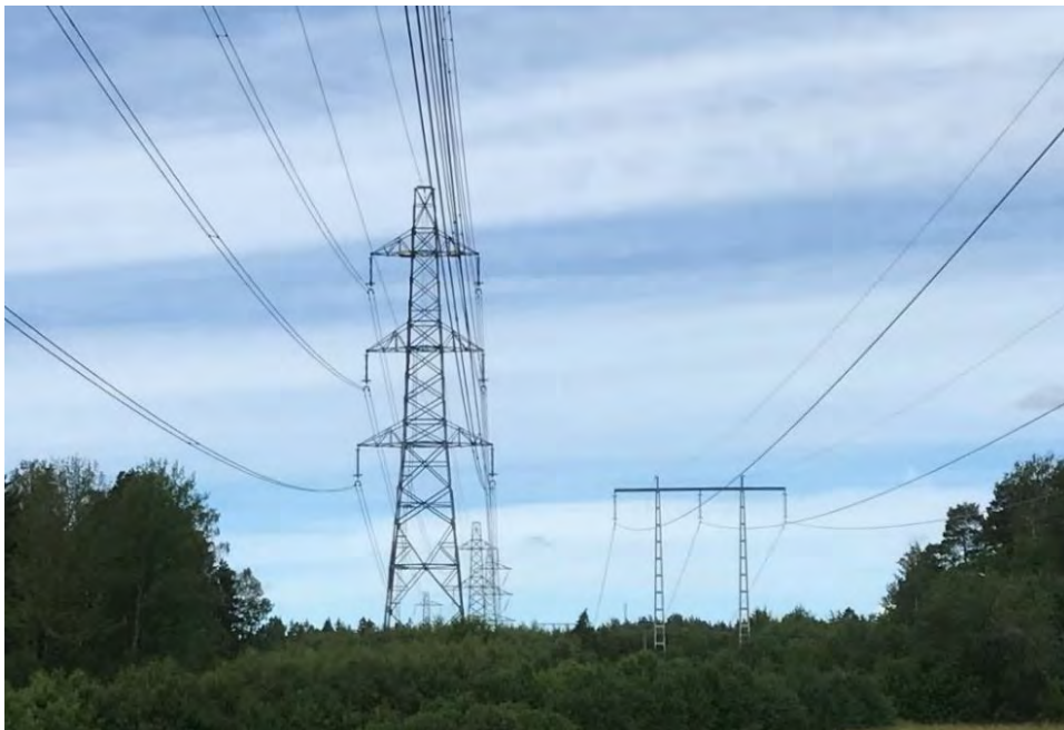
Figur 2. Utformning och foto på befintlig sambyggd 220/400 kV-ledning (CL6 S 6-8/KL42 S4-7) i julgransstolpar som skall byggas om och justeras samt befintlig 220 kV-ledning (KL42 S 8) i portalstolpar som skall rivas mellan Odensala och Måby.
