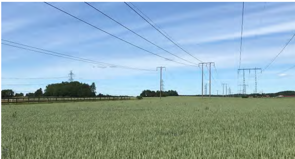
Figur 3. Befintlig och planerad ledningsgata i jordbruksmark vid Fjällsta gård, vy mot norr. Från vänster till höger syns Svenska kraftnäts sambyggda ledning KL 42 S4-7 och CL6, Trafikverkets 2x66 kV, Vattenfalls 70 kV samt Svenska kraftnäts 220 kV KL42 S8 som ska rivas.
