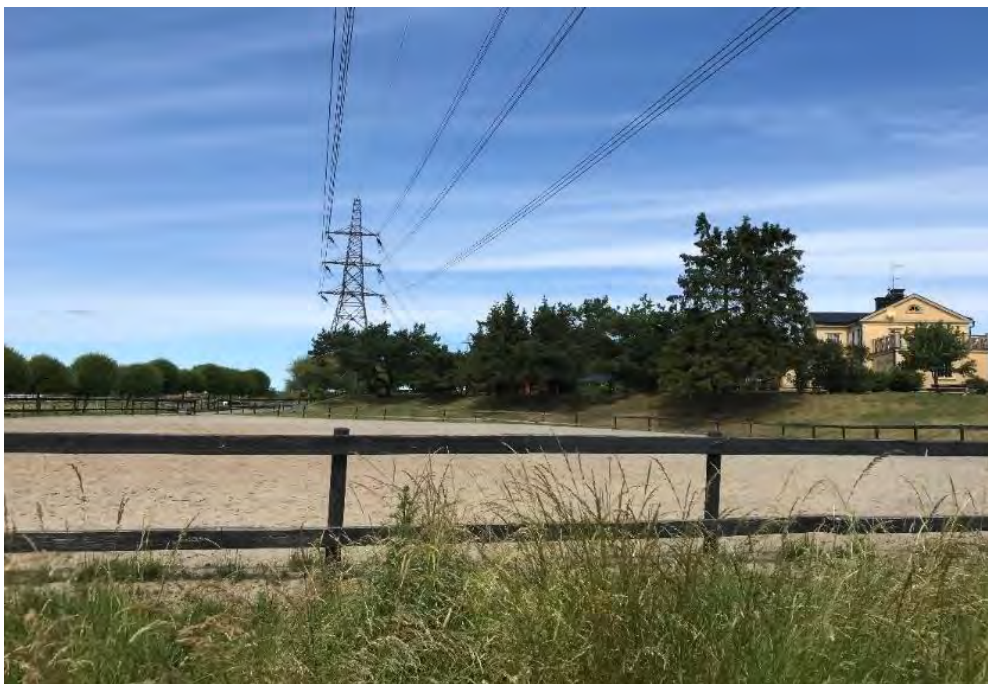
Figur 8. Befintlig ledning som idag går väster om Fjällsta gård. Den sambyggda ledningen planeras öster om gården längs befintliga ledningsgator för att minska påverkan på gården. Efter etablering kommer ledningen i bild att kunna rivas. Vy mot norr.
