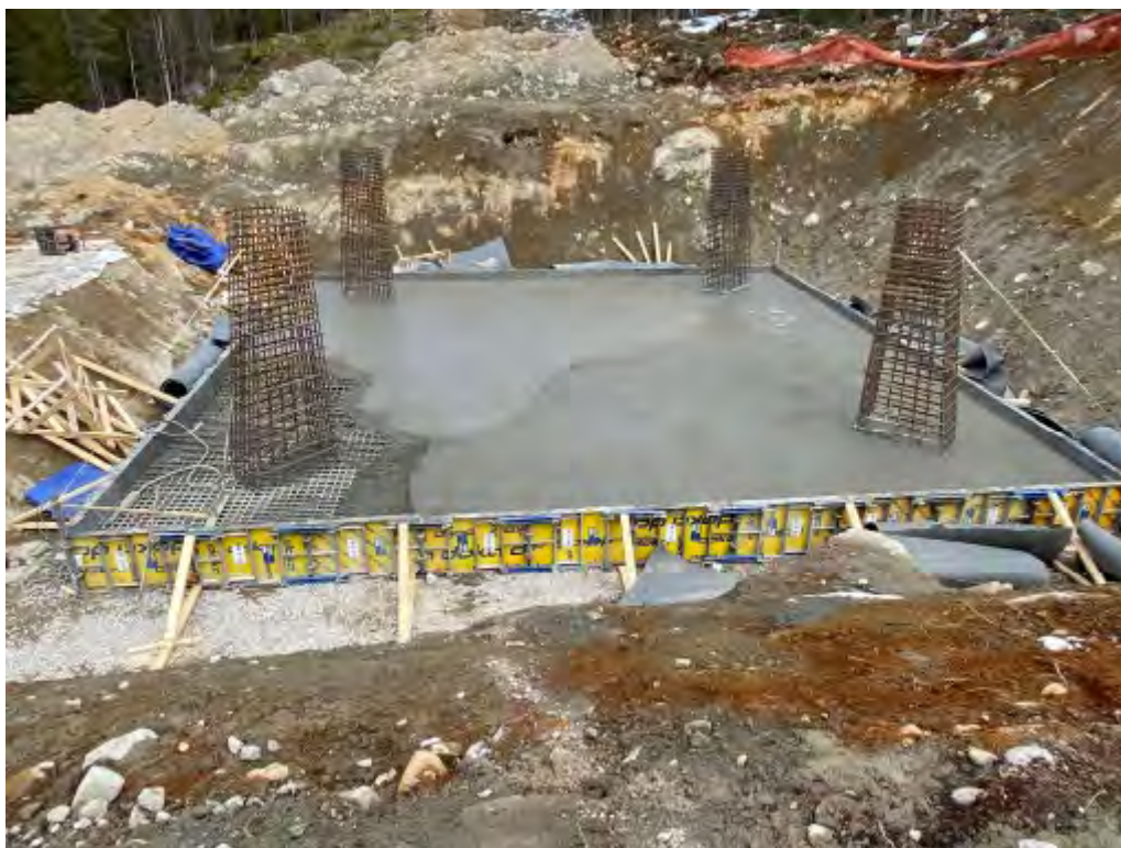
Figur 7 Exempelbild på fundament för stolparna. Gjutningen är inte färdigställd.
