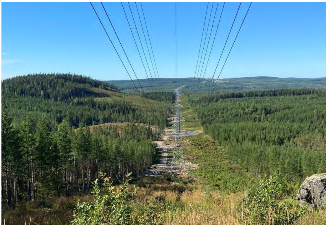
Figur 6 Dubbelledningen mellan Tovåsen och vindpark Björnberget. Foto taget mot station Tovåsen som kan anas i fjärran. Skogsgatan som syns i fotot är i nuläget bredare än vad som kommer behövas på sikt. Anledningen är att en befintlig 130 kV ledning var kvar och i drift väster om stålstolpsledningen medan den nya ledningen byggdes. På detta foto är den gamla träportalsledningen raserad. Träd kommer att kunna växa upp i västra delen av skogsgatan (till höger i fotot) så att dess bredd på sikt minskas.
