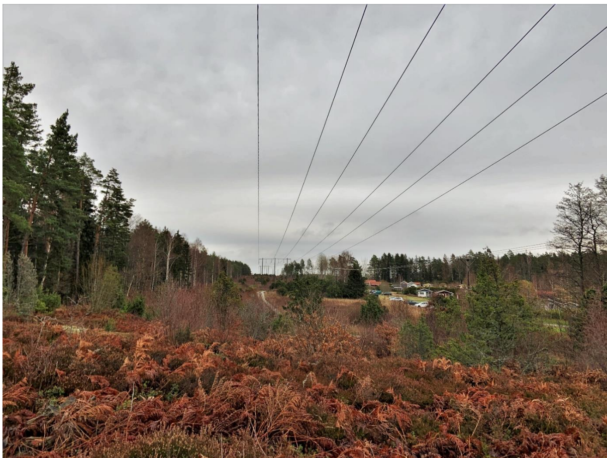
Figur 13. Befintliga ledningar vid sommarstugeområdet Myggdansen. Aktuell ledning planeras väster om befintliga ledningar. Bilden är tagen mot Tjusta; nordost.
