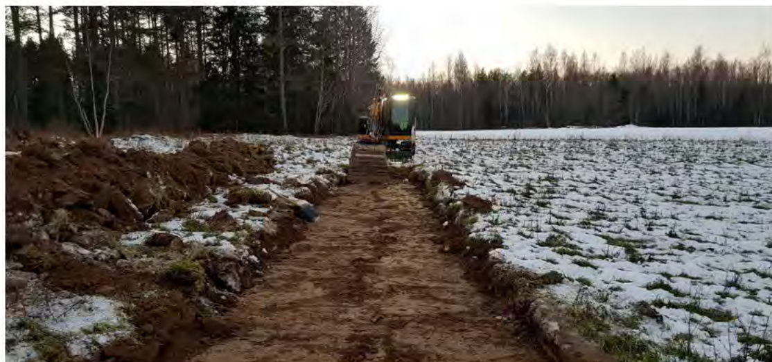
Figur 16. Schaktdragning med maskin. Under det 0,3-0,4 m tjocka matjordslagret var fin rödaktig sand.
