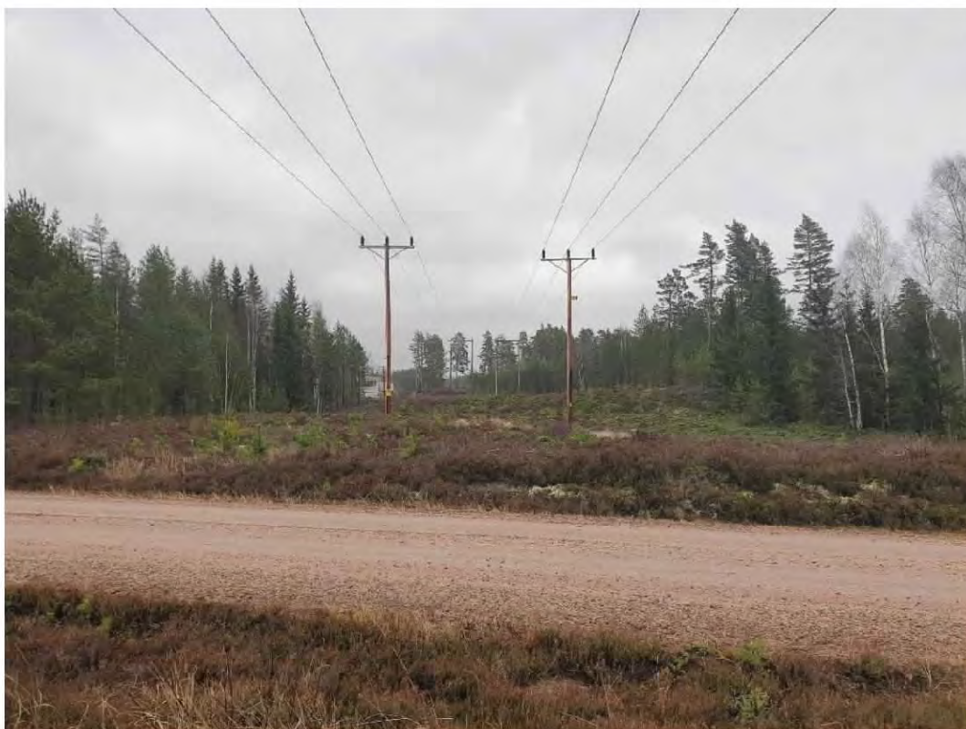
Figur 2. Enbenta trästolpar tillhörande KL 60 (vänster) och KL61 (höger).
