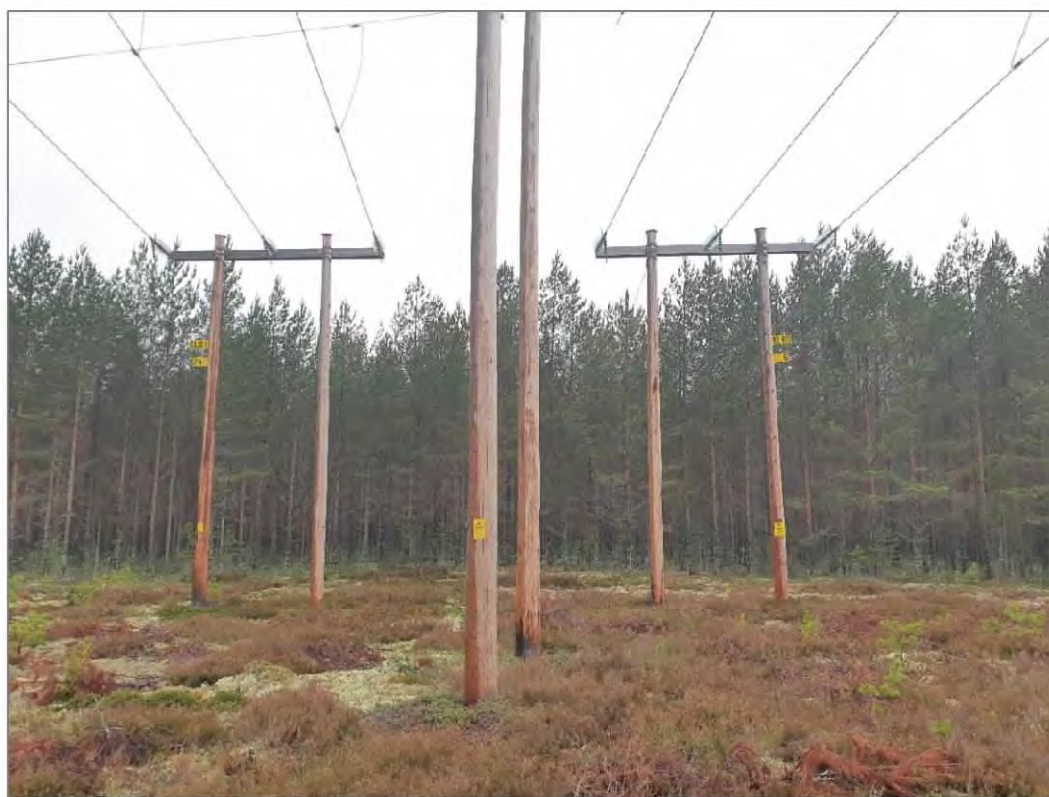
Figur 3. Portalstolpar i trä tillhörande KL60 (höger) och KL61 (vänster).
