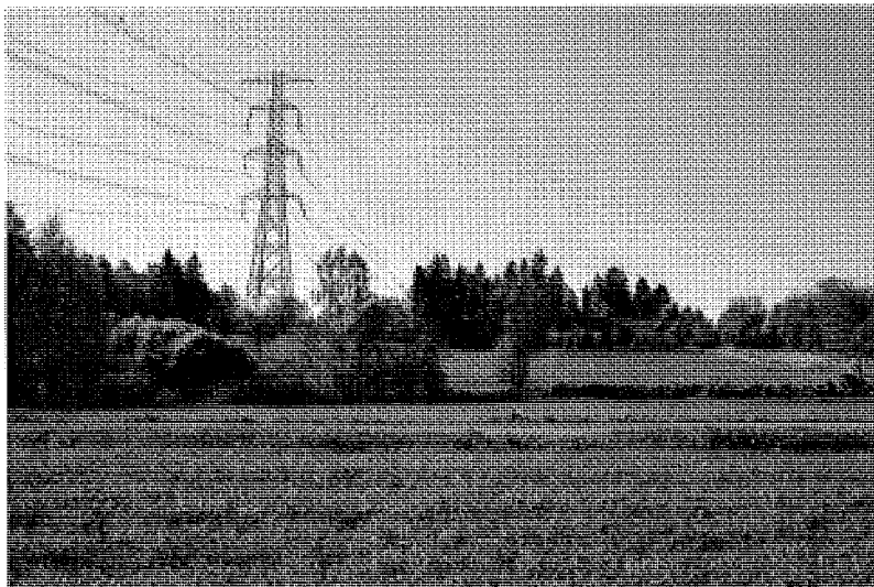
Fig.11 Ledningen (FL7 S3-4) sambyggd i julgransstolpar med (FL12 S3-4) nära bebyggelse vid Lingshult.
