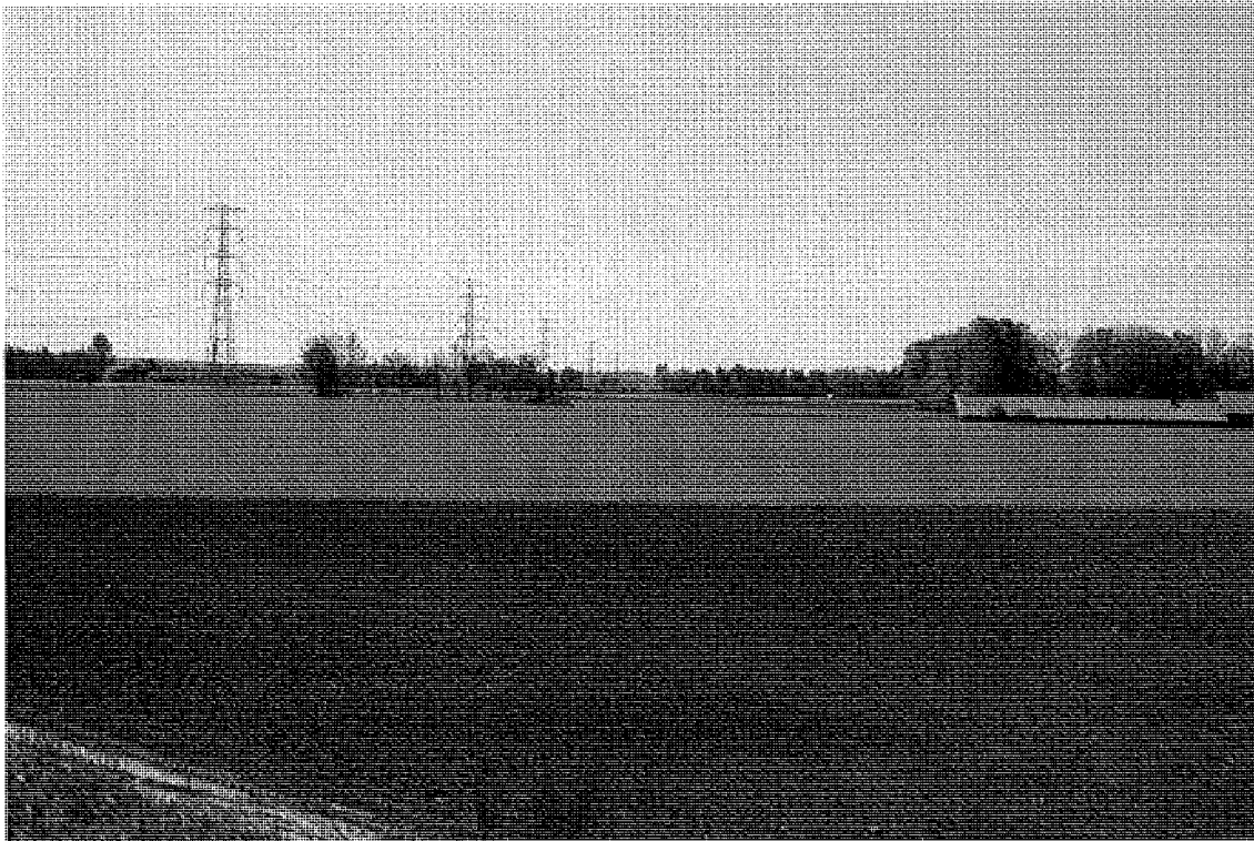
Fig. 14 Ledningen (FL7 S3-4) är sambyggd i julgransstolpar med 400 kV ledning (FL12 S3-4) i det öppna jordbrukslandskapet.
