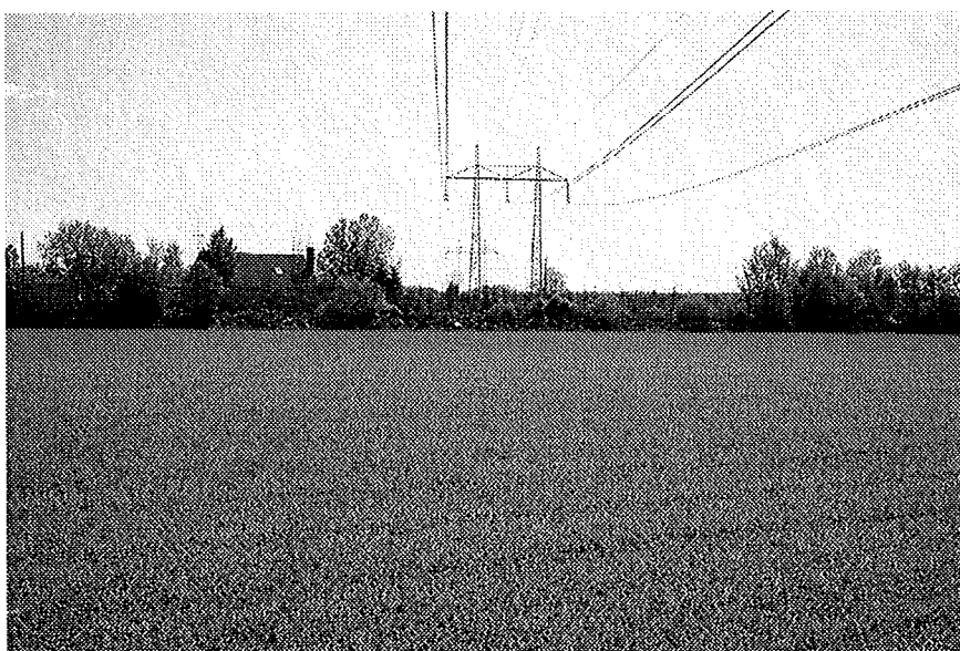
Fig.17 Ledningen (FL7 S5-6) går i portalstolpar över jordbrukslätten. Enstaka bostadshus ligger relativt nära ledningen.
