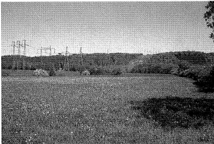
Fig.16 Ställverket vid Söderåsens sydsluttning. Ledningen övergår från sambyggd julgransstolpe till portalstolpar.
