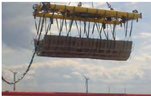
Figur 2.27 Utplacering av betongmatta.
