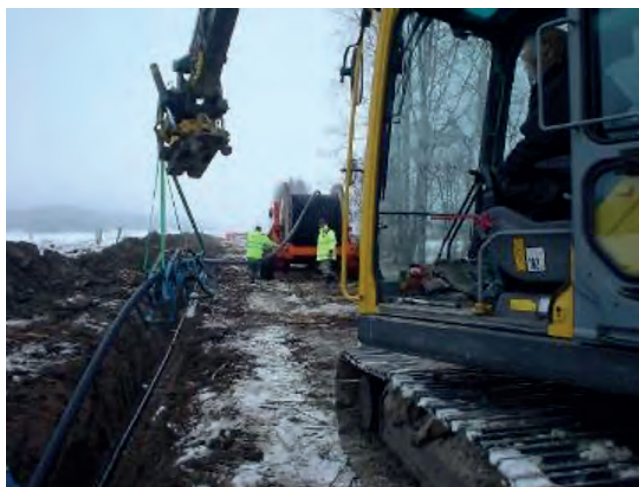
Figur 2.8 Kabelförläggning från trumvagn.
