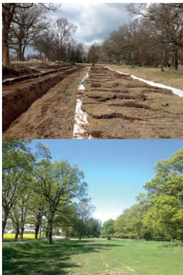
Figur 2.16 Kabelstråk under anläggningsfasen (ovan) samt ca 2 år efter kabelinstallation (nedan).
