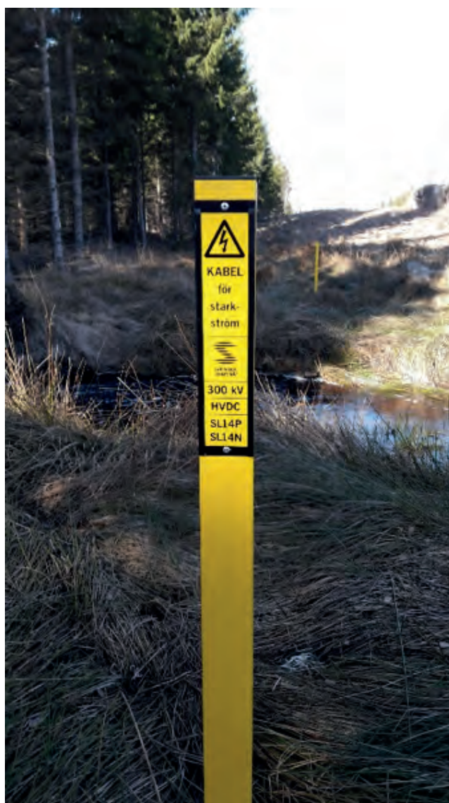
Figur 2.15 Kabelmarkeringsstolpe.
