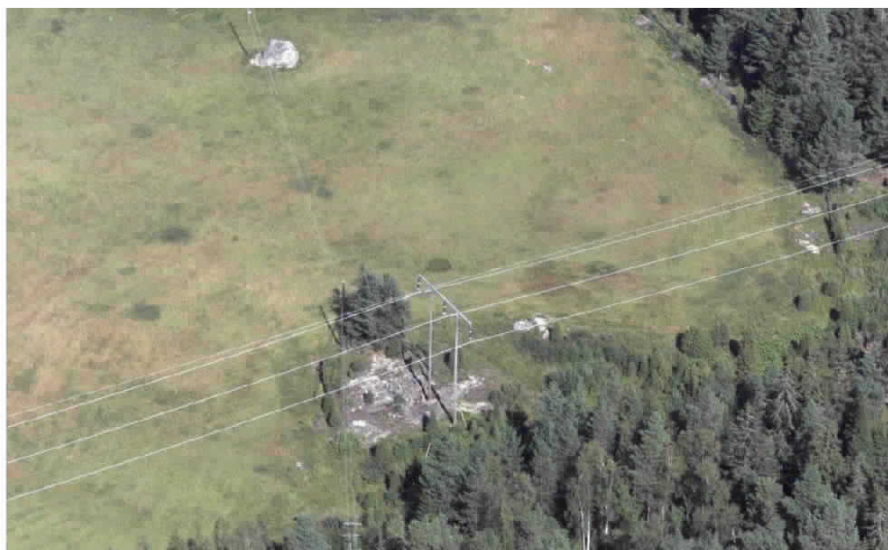
Figur 4. Aktuell stolptyp för befintlig ledning.
