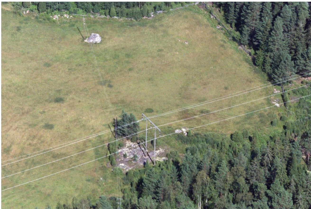
Figur 5.2 Bild över aktuell kraftledning och stolptyp.
