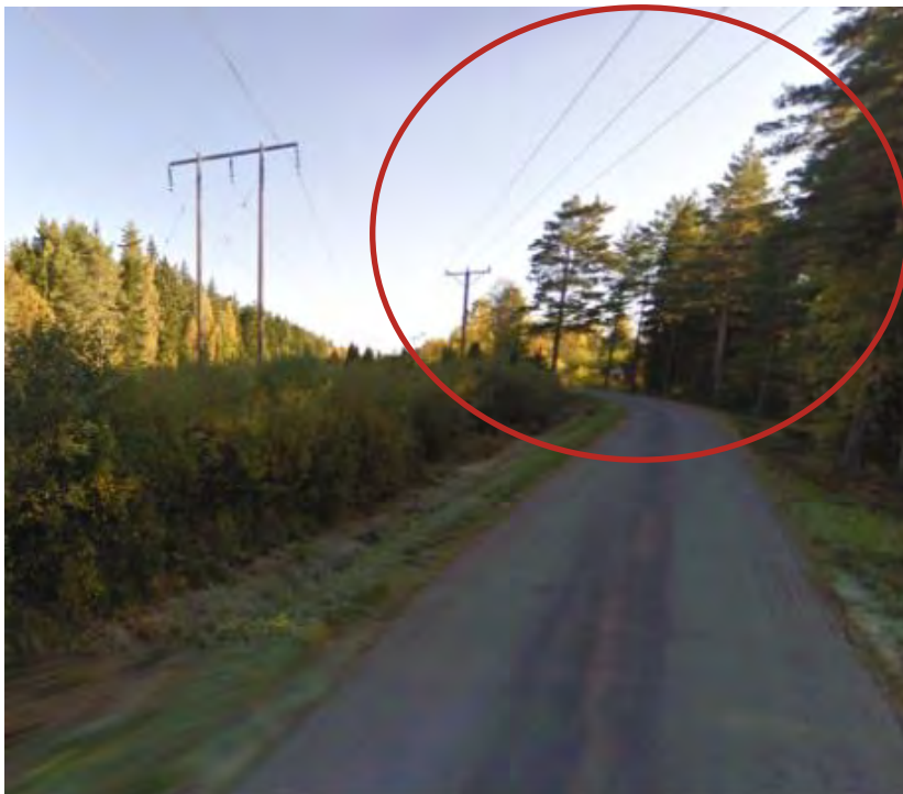
Figur 3 Bild på Nybro Elnäts 20 kV-ledning i höjd med Markustorp. I skogsgatan finns även E.ON:s 130 kV-ledning (vänstra).
