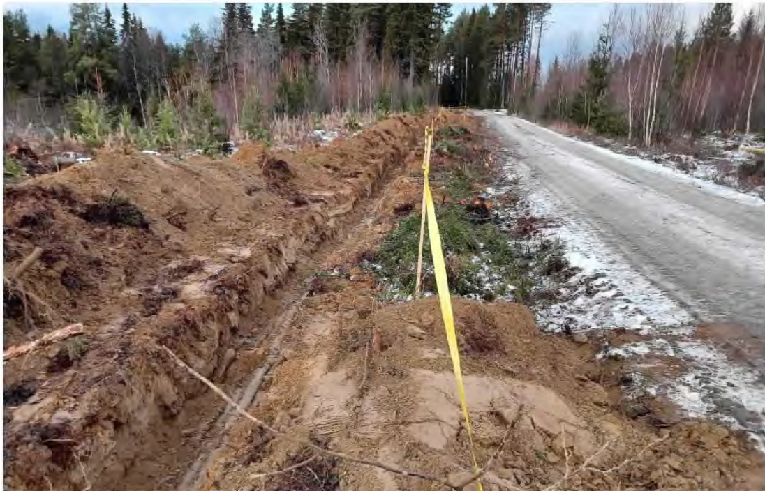
Figur 7. Exempelbild kabelschakt vid väg. På bilden dock lokalnät som grundläggs ytligare och med smalare schakt. Bild från vägen vid Näsåker transformatorstation.
