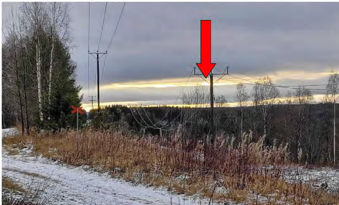
Figur 3. Exempel på aktuell stolptyp (40 kV regionnätstolpe) till höger i bild, från byggnation av 40 kV ledning Forsmo-Näsåker. Fasadståndet är utökat till 1600 mm (normalt enligt standard är 1350 mm), isolatorernas höjd är ca 600 mm. Till vänster i bild syns en motsvarande lokalnätstolpe med lägre spänning. Fasadståndet är avsevärt mindre liksom höjden på isolatorerna. Slutlig utformning kan avvika från bilden. (Observera att faslinorna på 40 kV ledningen inte är uppspända på bilden)
