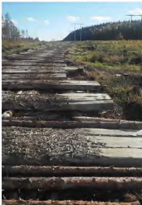
Figur 18. Exempel på prefabricerade stockmattor som tillfällig körväg på våtmark. Bild från byggnation av 130 kV ledning i Sundsvalls kommun.
