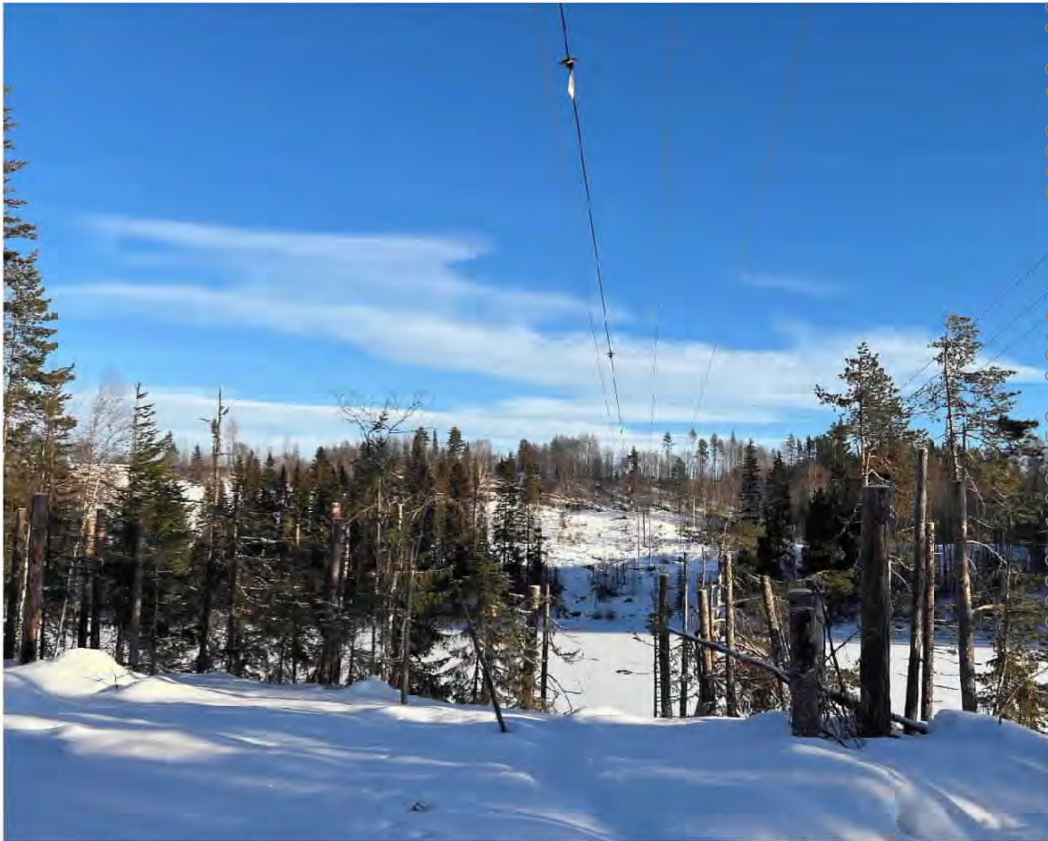
Figur 10. Foto över befintlig 40 kV ledning Forsmo-Näsåker där den korsar Ångermanälven. Älven är isbelagd i bilden. Till höger i bild anas en befintlig 10 kV ledning. 40 kV ledningen har utrustats med fågelavvisare. Utförandet och utseendet kommer att vara likartat för den nya ledningens passage över älven och bedöms inte vara iögonfallande.
