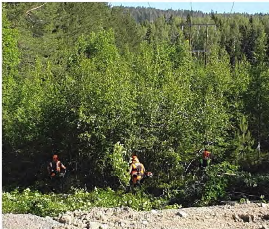
Figur 8. Exempelbild, manuell röjning av skogsgata under ledning.
