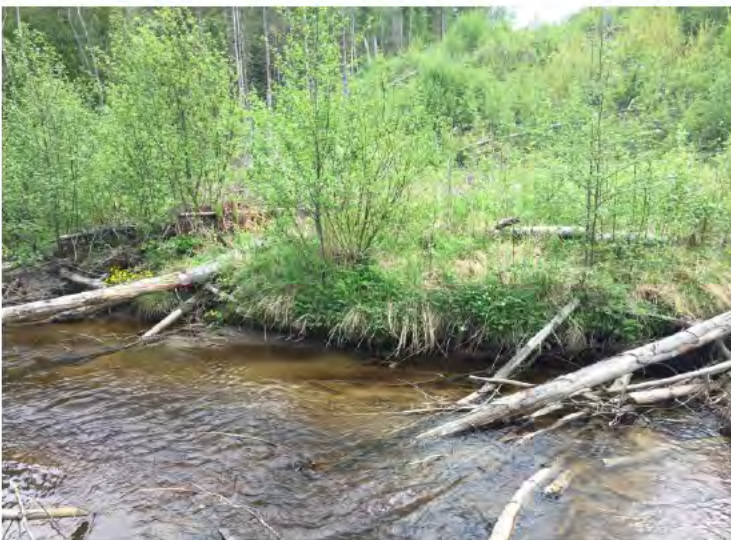
Figur 3. Vy över strandområdet där ledningen byggts över Sulån.
