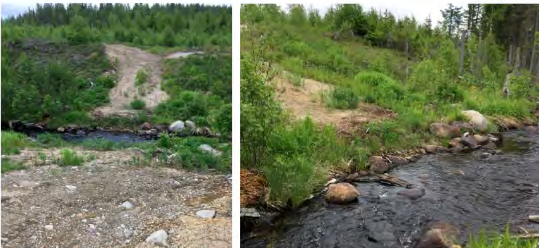
Figur 7 och 8. Vyer över ledningsspässagen vid Börkelån.
